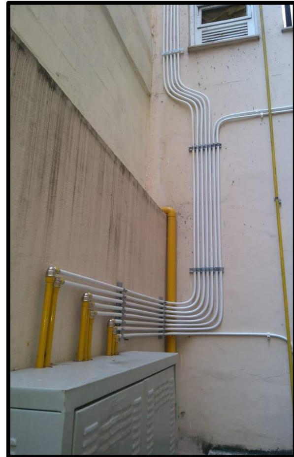
Serviço: Construção de instalação com tubo de MULTICAMADA
