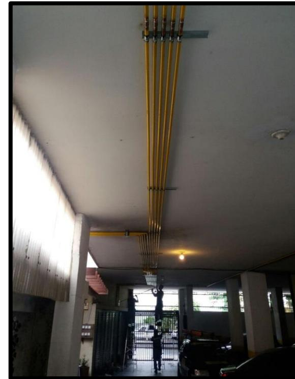
Serviço: Construção da tubulação de gás com COBRE
