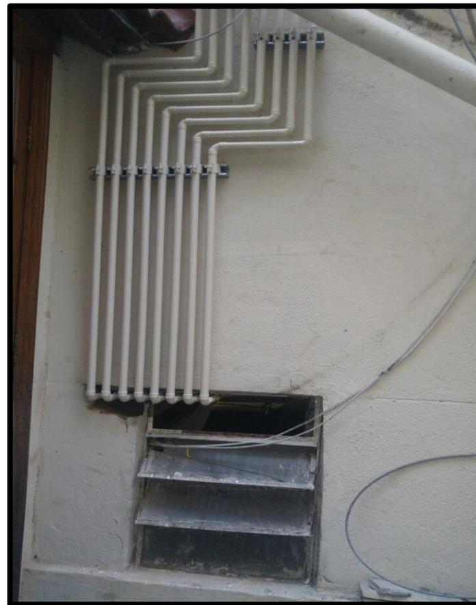
Serviço: Construção de instalação com tubo de MULTICAMADA
