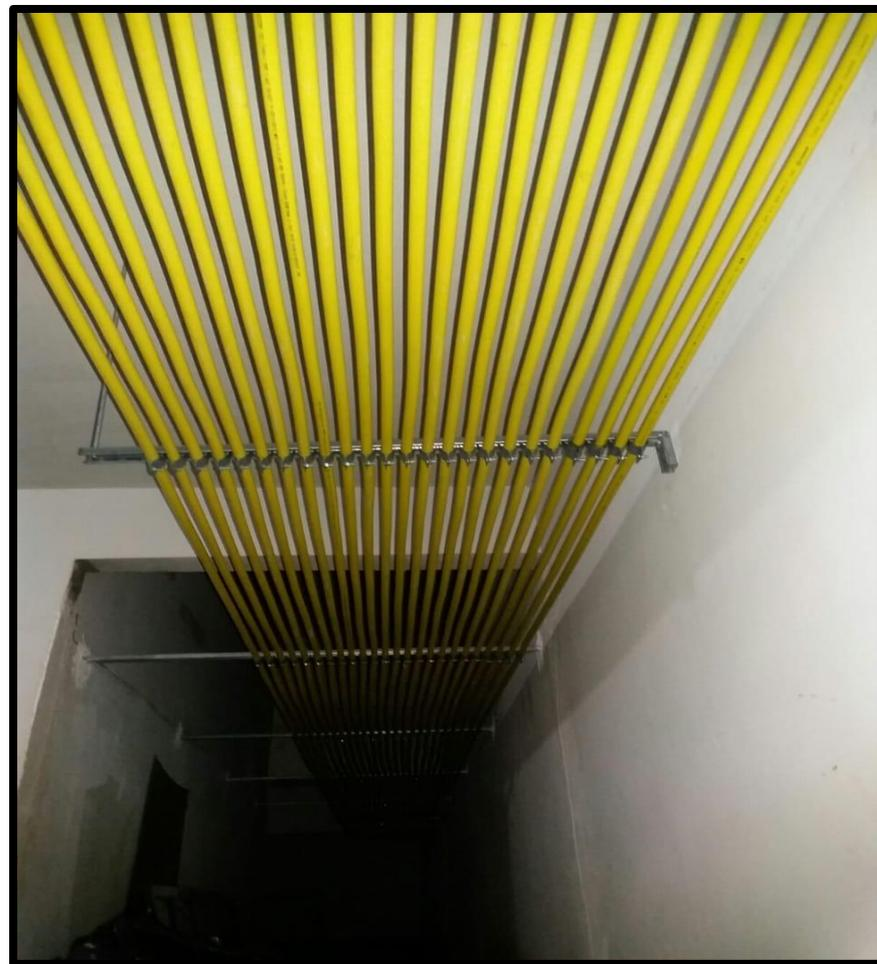
Serviço: Construção de instalação de gás com COBRE .
