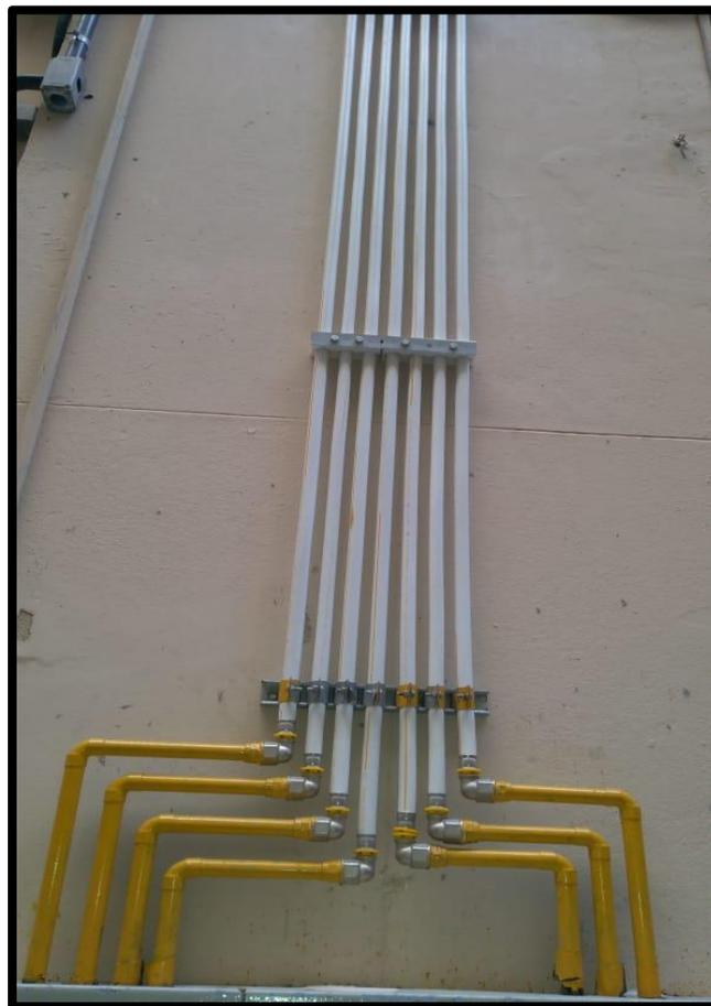
Serviço: Construção de instalação com tubo de MULTICAMADA
