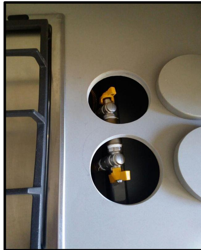
Serviço: Instalação de aquecedor e válvula de fácil acesso do ponto do fogão .
